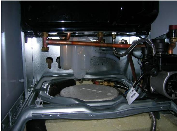
2. Installare la valvola di ritegno (con chiusura verso la caldaia) in uscita dal generatore e la tubazione di mandata solare.
