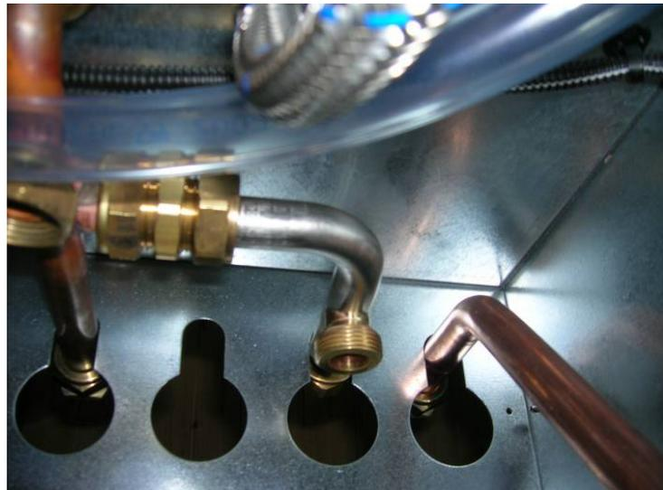
3. Installare la tubazione di mandata al bollitore solare.
