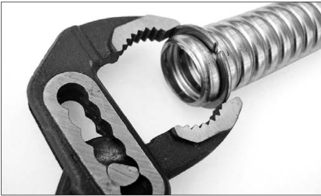
Montare la rondella di serraggio
