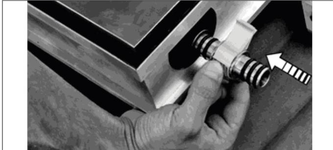
Inserire i connettori idraulici centrali al primo pannello (sopra e sotto), senza togliere il manicotto distanziatore.
