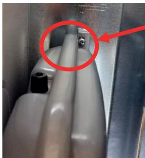
8. Montaggio della staffa per il fissaggio definitivo del vaso d'espansione tramite le ultime 2 viti. Queste dovranno essere avvitate sulla spalla destra dopo che la staffa è stata posizionata sul vaso.
